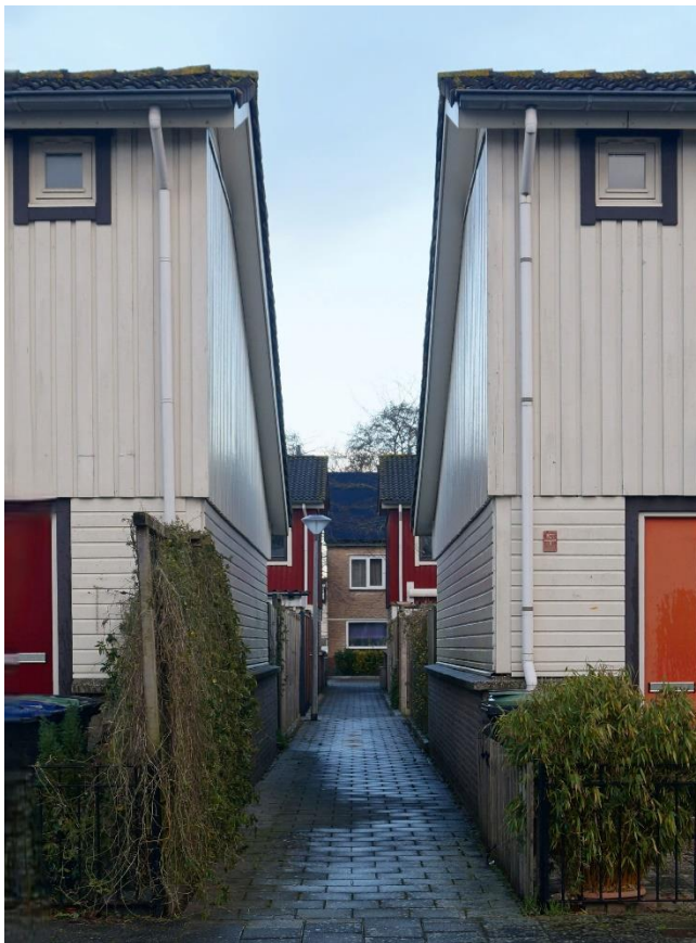
Figuur 6.3: Verschillende entrees en steegjes tussen de woningen zorgen voor enige variatie in de Bouwmeesterbuurt. Bron: auteur.
