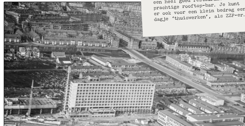
‘Casa 400 in aanbouw, circa 1959. Foto: Aviodyne, Lelystad.’
