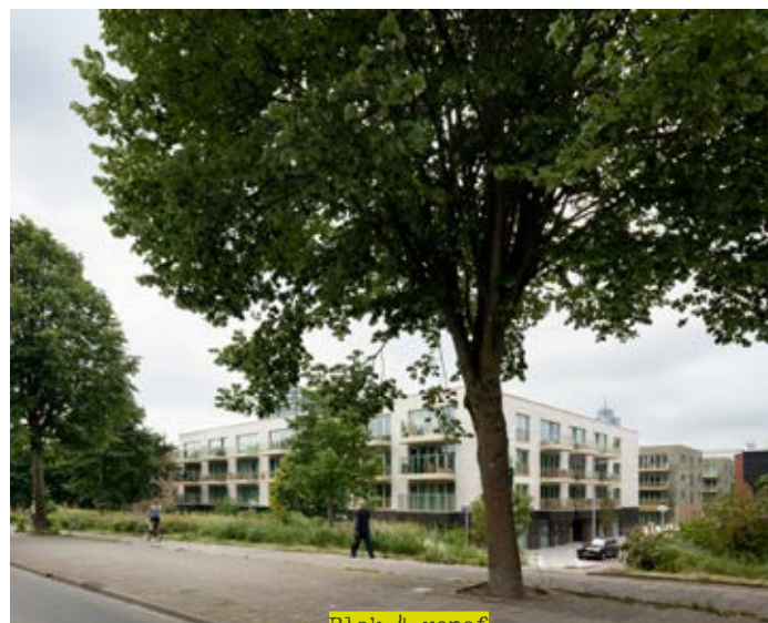
Blok 4 vanaf de Nobelweg
