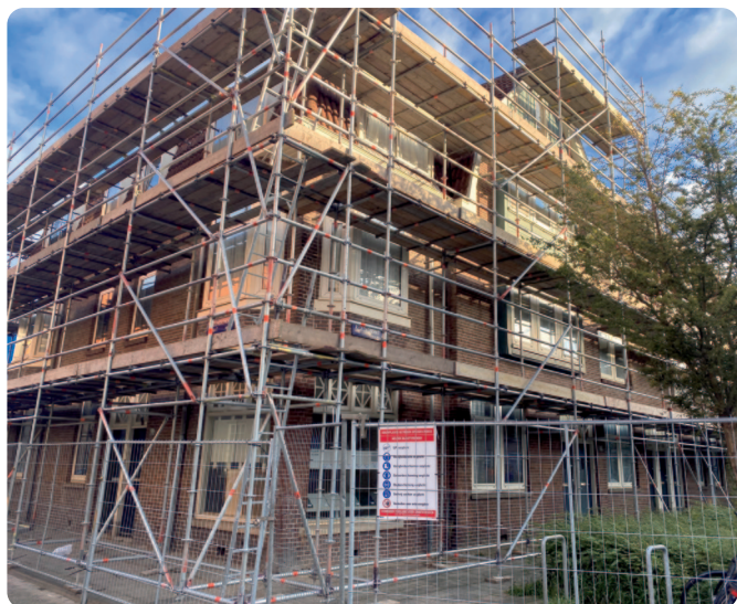
Blok 6 en 7 staan in de steigers
