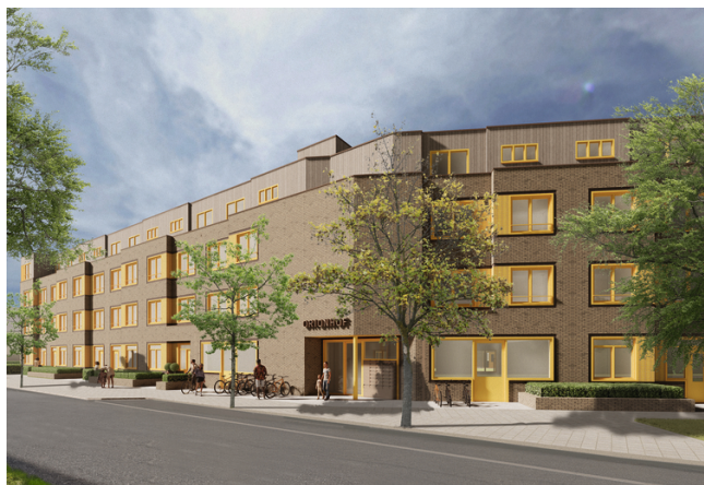
Impressiebeeld van de nieuwbouw: gevel Hélène Swarthstraat
