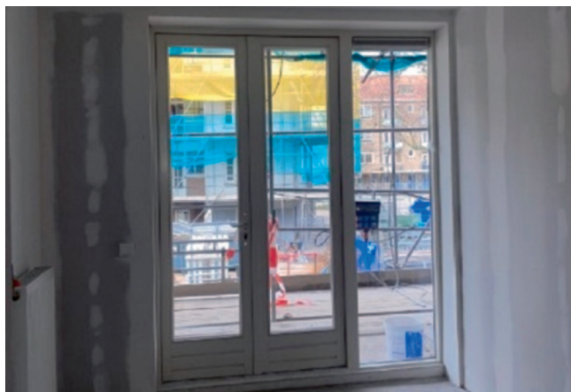
Nieuwe gevelkozijnen en geïsoleerde voorzetwanden
