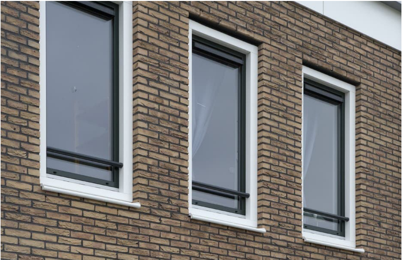
Fig. 2B.5 Voorgescreven type doorvalbeveiliging met verborgen montage
