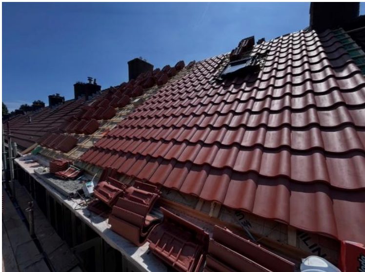
Het nieuwe dak
