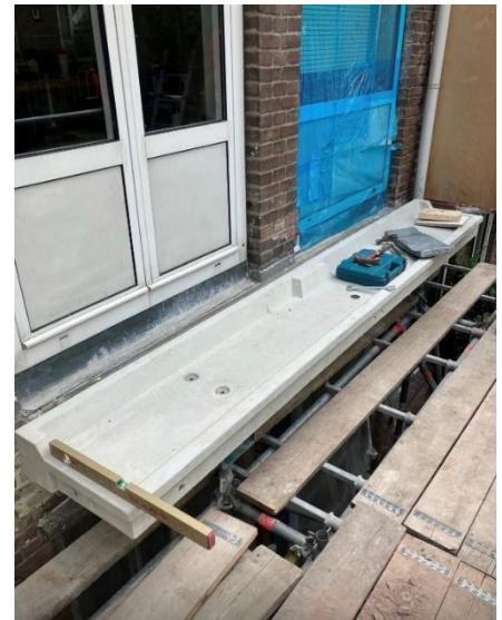
Het nieuwe balkon is geplaatst
