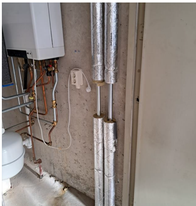
Foto van de buizen die worden aangebracht in de CV kast
