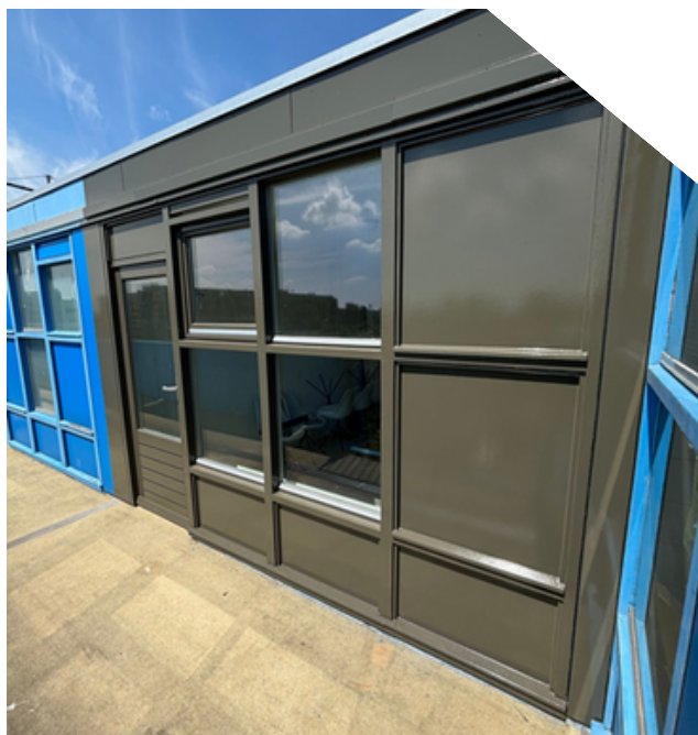
Foto van de nieuwe ramen van een galerijwoning
