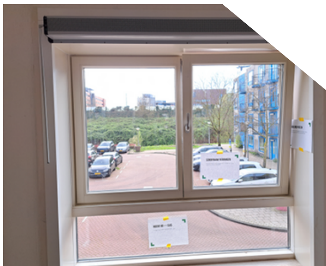
Foto van de nieuwe ramen vanuit de binnenkant
