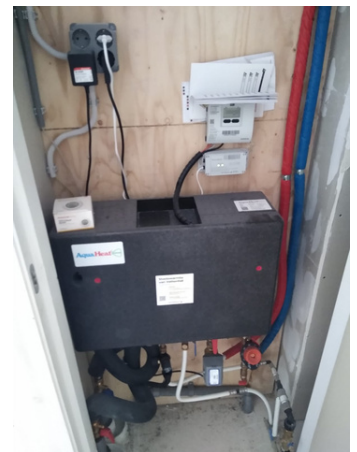
Afleverset van een warmtenet
