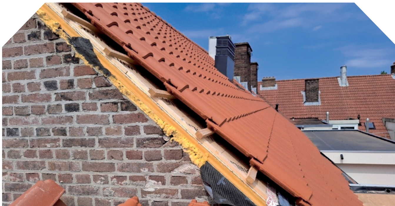
Hier ziet u hoe het dak is geïsoleerd
