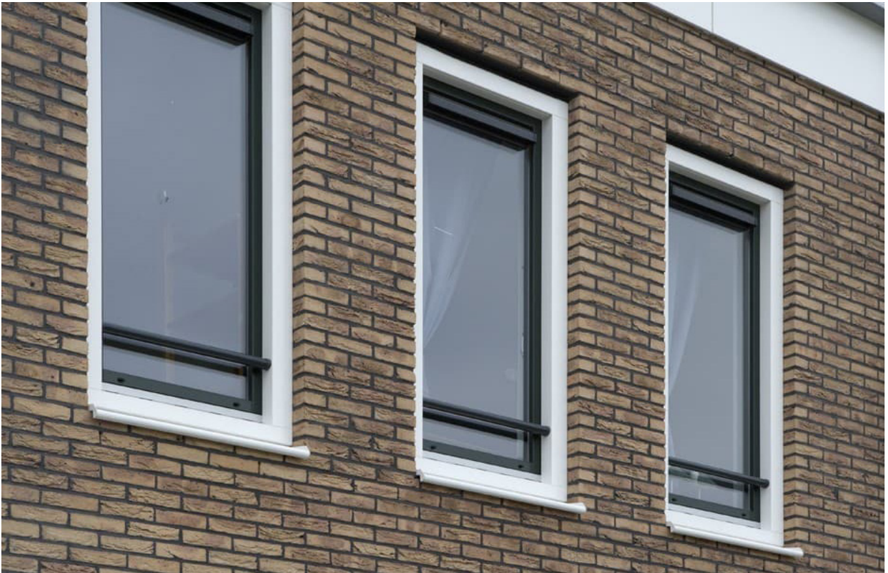
Fig. 2B.5 Voorgeschreven type doorvalbeveiliging met verborgen montage
