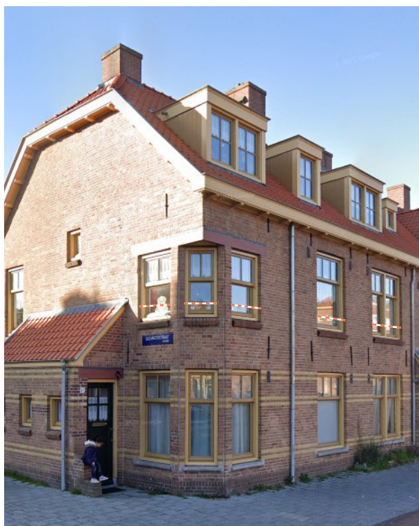
Fig. 2B.4 Voorbeeld positie doorvalbeveiliging
