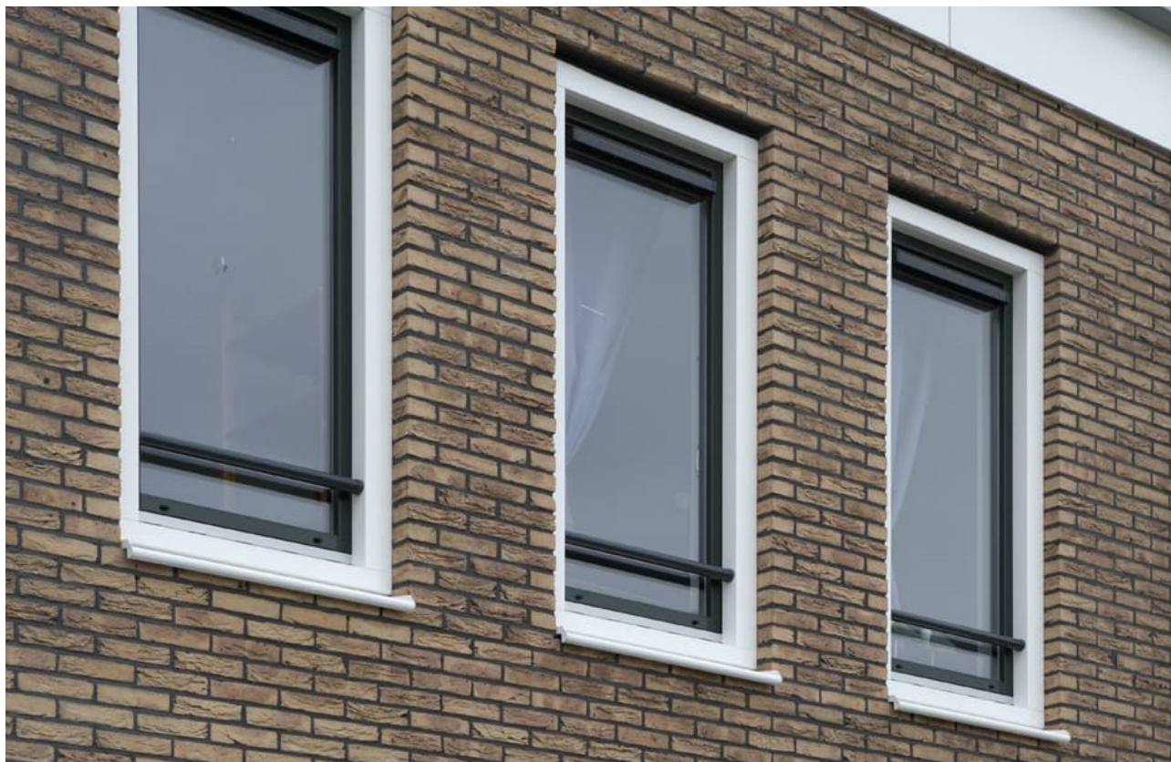
Fig. 2B.5 Voorgeschreven type doorvalbeveiliging met verborgen montage
